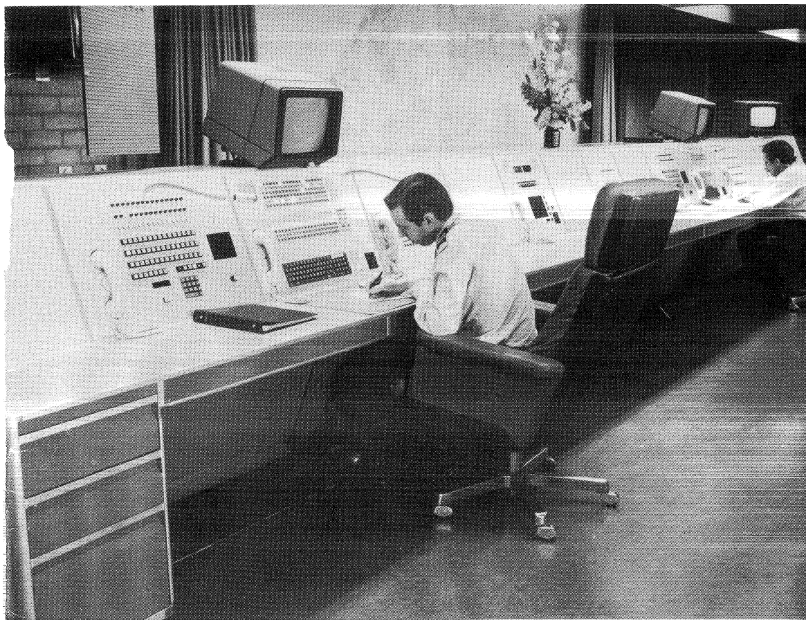
Uitgebreide bedieningstafel met concentratieschakeling (Brandweer Rotterdam)
