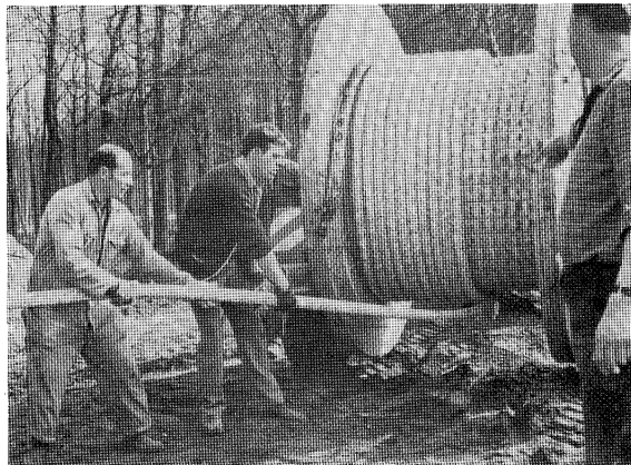
Het kabelleggen is een werk waarbij nog steeds veel mankracht aan te pas komt.
